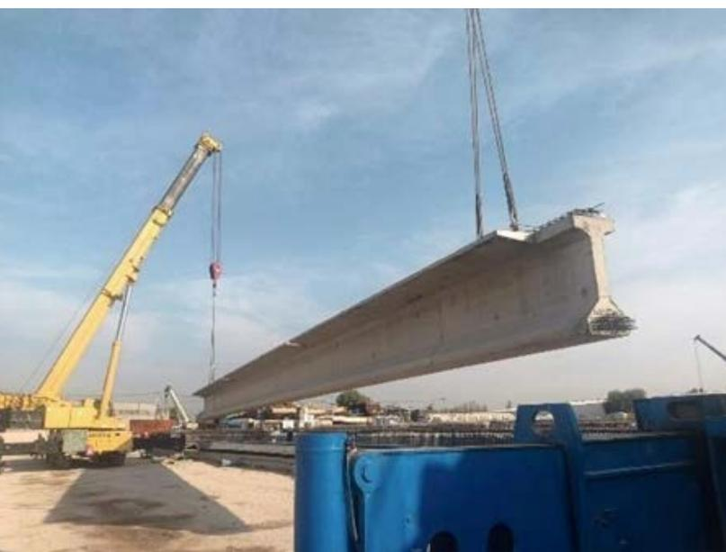
Figura 2. Descimbrado y movimiento de los elementos prefabricados.
