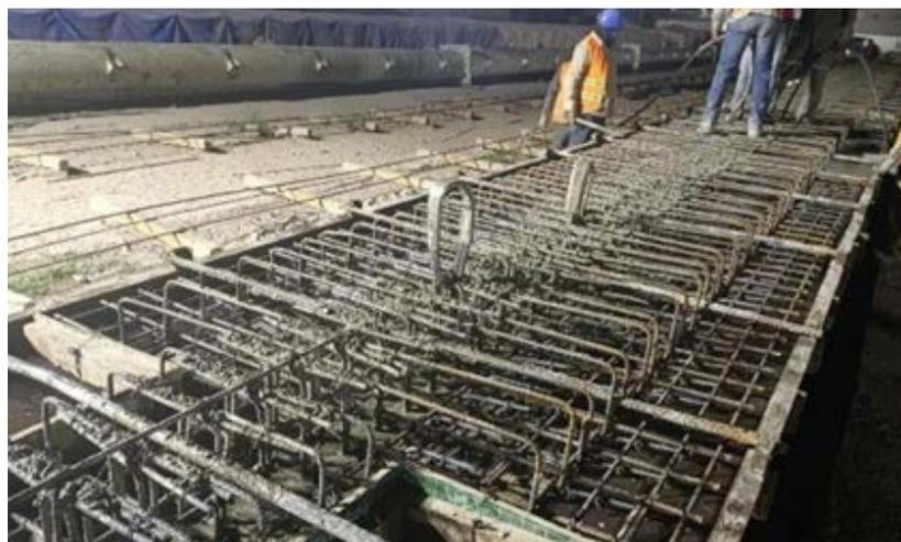
Figura 3. Colado de elementos prefabricados HOLPRE. Atitalaquia, Estado de Hidalgo, México.
